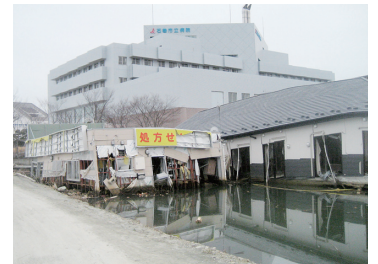
損壊した石巻市立病院と薬局
