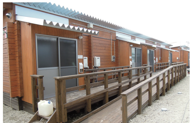
▲福島県内で約5500カ所の建設が進む木造型応急仮設住宅
