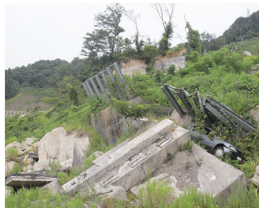
◀写真1 妙見崩落現場 信濃川の水際には崩落した当時の道路や自動車が残っている。計画高水位との関係などからその扱いについては難航したが、存置する方向で最終調整に入っているそうである。
