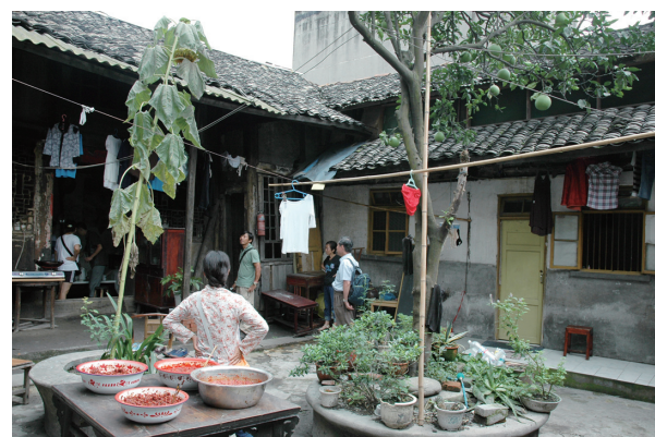
◀被害のなかった伝統木造建築（都江堰）
