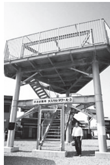
写真1 避難困難地域に設置された津波避難タワー (和歌山県串本町串本地区) 2009年5月31日読売新聞
