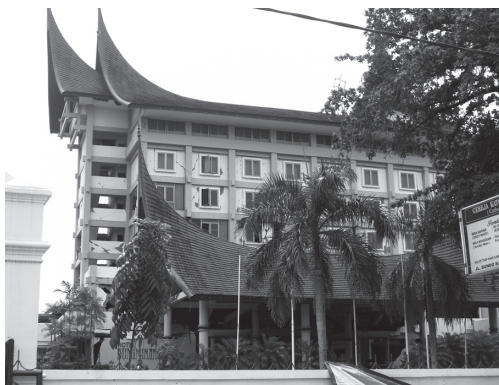
図2 損壊して完全に閉鎖された伝統的様式を取り入れたホテルの外観(津波避難予定ビル)
